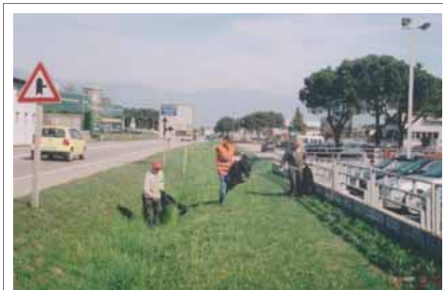
Gli Alpini di San Fior al lavoro nella pulizia delle scarpate
