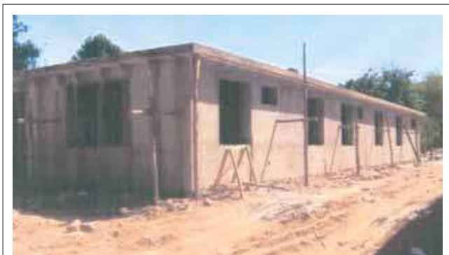
La costruzione prende forma
