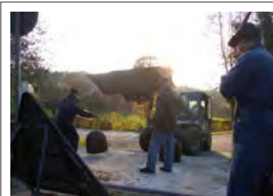
Ripristino del Vicolo degli Alpini
