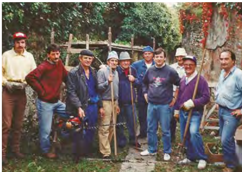
Lavori di manutenzione Calle della Madonna
