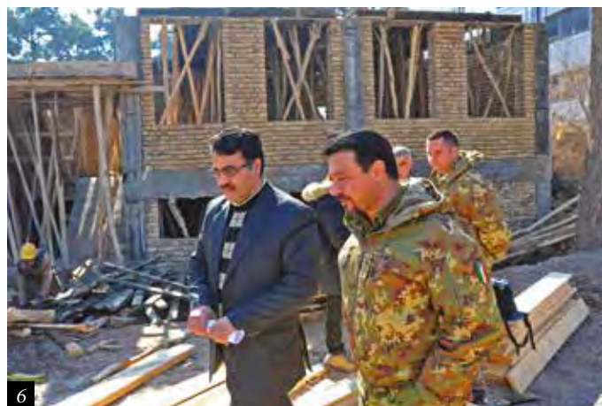
6 Ispezione a uno dei cantieri nella Provincia di Herat
