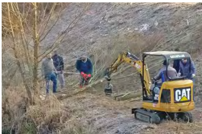
Alpini al lavoro sull’argine
