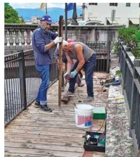
Sostituzione tavole ammalorate
